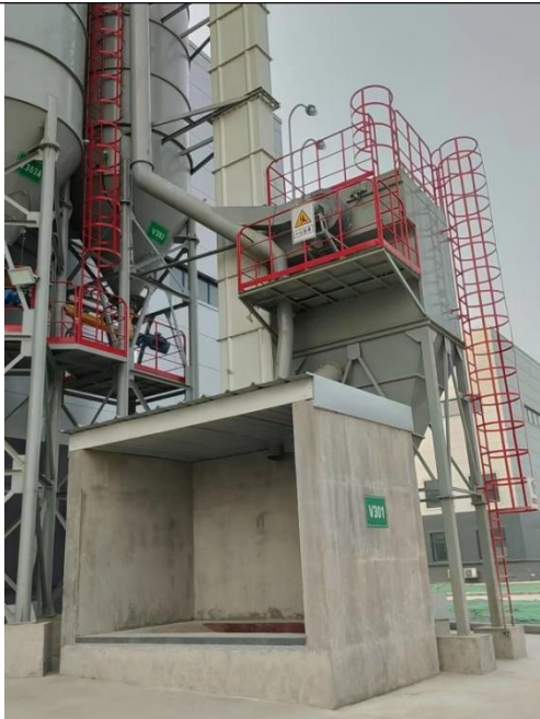
3面挡墙及顶盖
