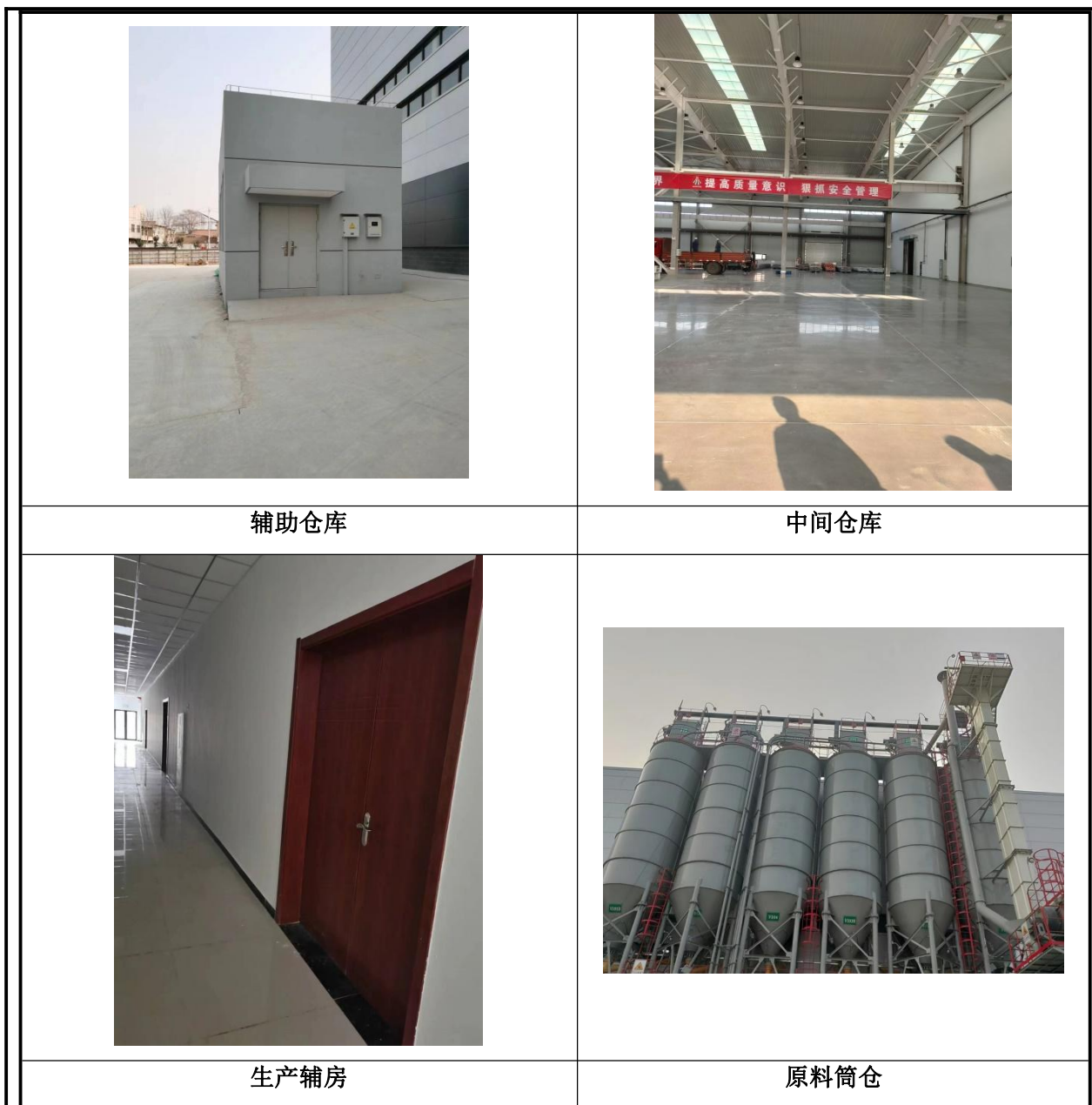
图 2-1 项目实际建设情况
